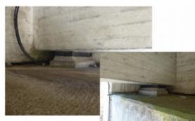
Foto 7aH: Auflagerbetone (Orf West) und Eisenbetondeckung ohne erkennbare Schäden
